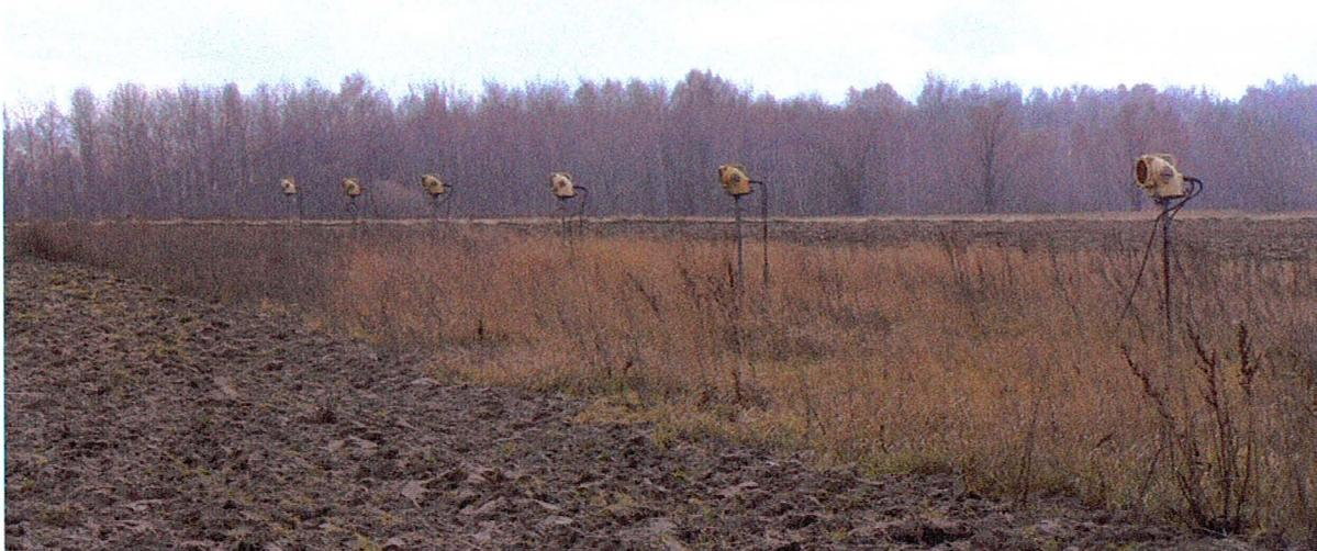
Из представленной выше фотографической документации следует, что светосигнальные элементы аэродрома Смоленск «Северный» происходили из ближе не определенной системы, в них не было отражателей ни собирающих линз, а также возможности регулировать угол освещения как в вертикальной, так и в горизонтальной плоскостях.
